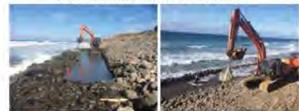
図：施工の様子（2014年10月、別笥）
