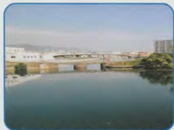
兵庫運河とJR和田岬線の レトロな鉄橋(平成25年)
