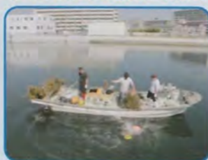
運河への設置
